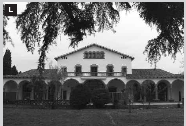
I: Vista aèria de l'Edifici SALT-TMS. J: Edifici Els Til·lers. K: Edifici La Mancomunitat 1. L: Edifici La Mancomunitat 2
